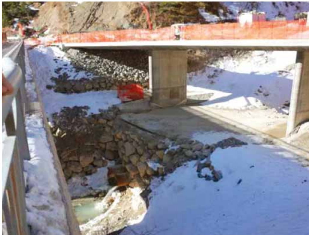
Il nuovo viadotto con un notevole restringimento di sezione libera dell'alveo del Rio della Cà. (Fig. 15)
